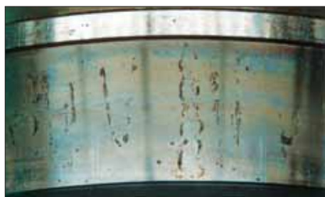
Rdza i korozja
